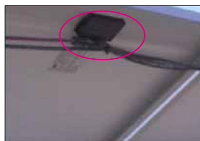
Aansluit- en beveiligingsdiodekast
